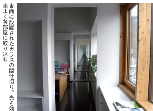
開口部。木製サッシ枠に高性能のトリプルガラスを採用した
