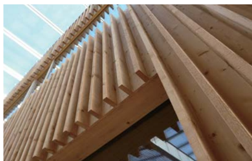
【12】外壁に使用した白モミの無垢材。1棟の使用量は約280㎡に達する
