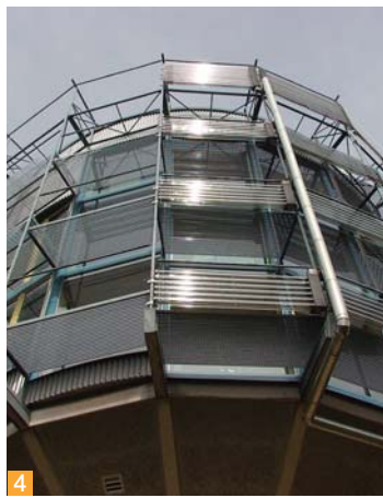
建物外壁のバルコニーに取り付けられた真空太陽熱温水器
