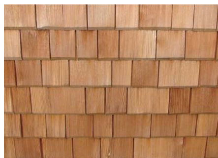
既存のRC外壁の上に充填断熱を施工し、地元伝統のカラマツを外装に施工した
