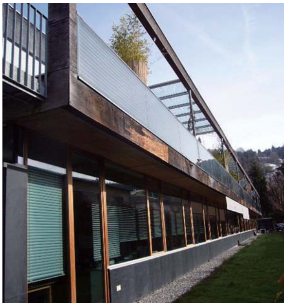
〔2〕バルコニーの手すりに取り付けられた太陽熱温水パネル
