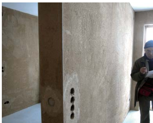
レンガ造壁表面に塗られた土壁。この中に温水パイプを回して壁暖房とする
