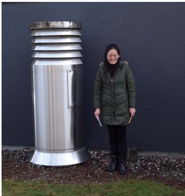
〔3〕地熱交換のために建物外周に設置した外気取り込み口
