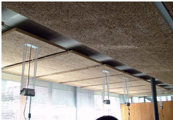
〔4〕省エネと低コスト化のため、建物内装の木毛セメント板を使用。外装仕上げにも合板を使った
