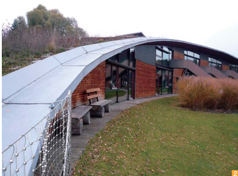
屋上緑化を採用した校舎屋上。漏水センサーを搭載することで防水施工のオーバーサペックを防ぐ
