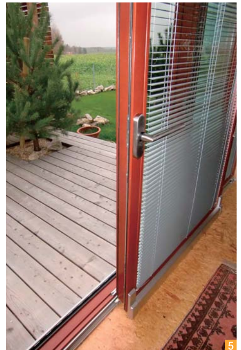
室内用のアルミブラインド。トリプルサッシの枠内にちょうど収まるため、天井のブラインドと干渉しない
