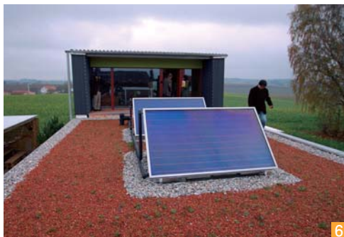
夏場使う温水をつくる太陽熱温水器。冬場はリビング・ルームに置かれたペレットストーブでまなかう
