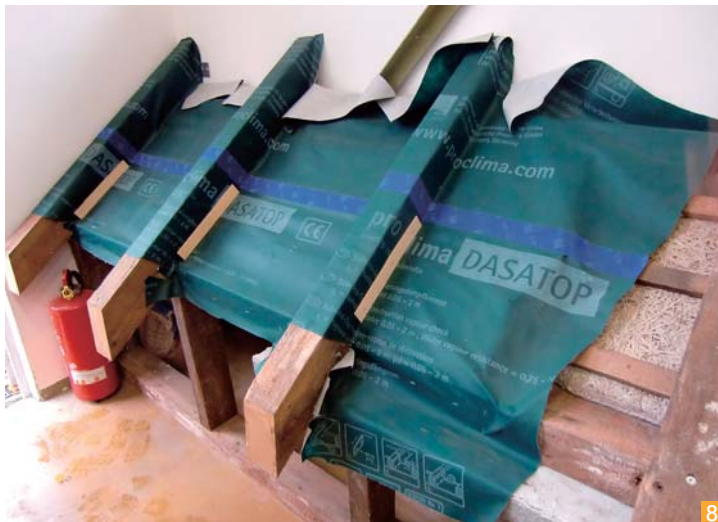
屋根改修専用の気密シート。屋根梁の外側から気密シートと断熱材を施工する際に屋根梁周囲での結露を防ぐために透湿抵抗値を若干低く設計してある
