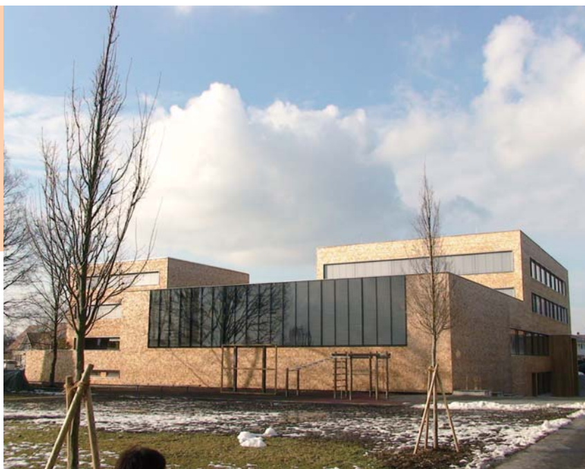
【概要】 学校・幼稚園 の改修/建築地 オーストリア・ヴォルフルト (Wolfurt) /混構造 (RC造+木造) /床面積 1850㎡ /2009年改築終了/案内役・設計者 Gerhard Zweier
