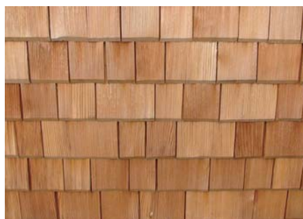
既存のRC外壁の上に充填断熱を施工し、地元伝統のカラマツを外装に施工した
