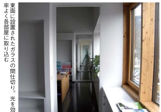
開口部。木製サッシ枠に高性能のトリプルガラスを採用した
