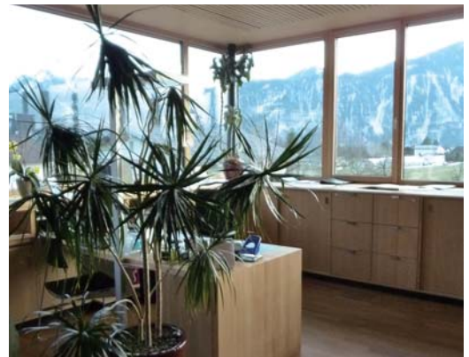
【13】内装の白モミ無垢材。無塗装とすることで、解体後は燃料となつて木の寿命を全うする
