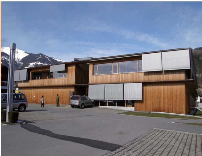
【概要】 村役場＋公民館の新築／建築地：オーストリア・ルーデッシュ (Ludersch) ／竣工：2005年／構造：木造／床面積：3135㎡ (うち40%はテナントが占める) ／設計者：Hermann Kaufmann／総工費：590万ユーロ (約7億6千万円) 設計料、コンサルタント・フィーなど80万ユーロ／案内役：元村長 ポール・アマン氏 (Paul Amann)
