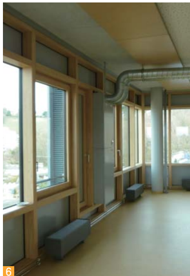
オフィス棟内部の腰壁部分にはトリプルガラスと同じ厚みの真空断熱材がはめ込まれていた
