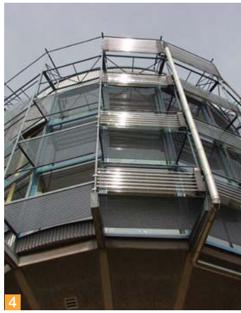
4 建物外壁のバルコニーに取り付けられた真空太陽熱温水器
